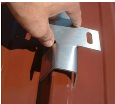
1. Schritt Schelle auflegen
