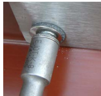
Beim Verschrauben auf leichte Pressung der Dichtung achten – bei größeren Stückzahlen mit Tiefenanschlag arbeiten!
