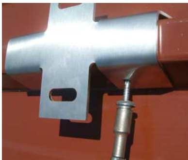
2. Schritt Verschrauben mit selbstbohrenden Schrauben
