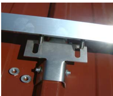
3. Schritt Querträger aufsetzen Zur besseren Kraftverteilung 2 Schrauben M10 verwenden!
