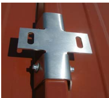
Schelle fertig gesetzt
